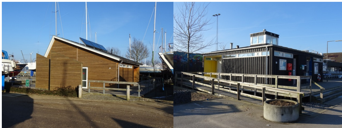
Servicebygningen på Marina Syd kan evt. genanvendes, men trænger til indvendig renovering.
